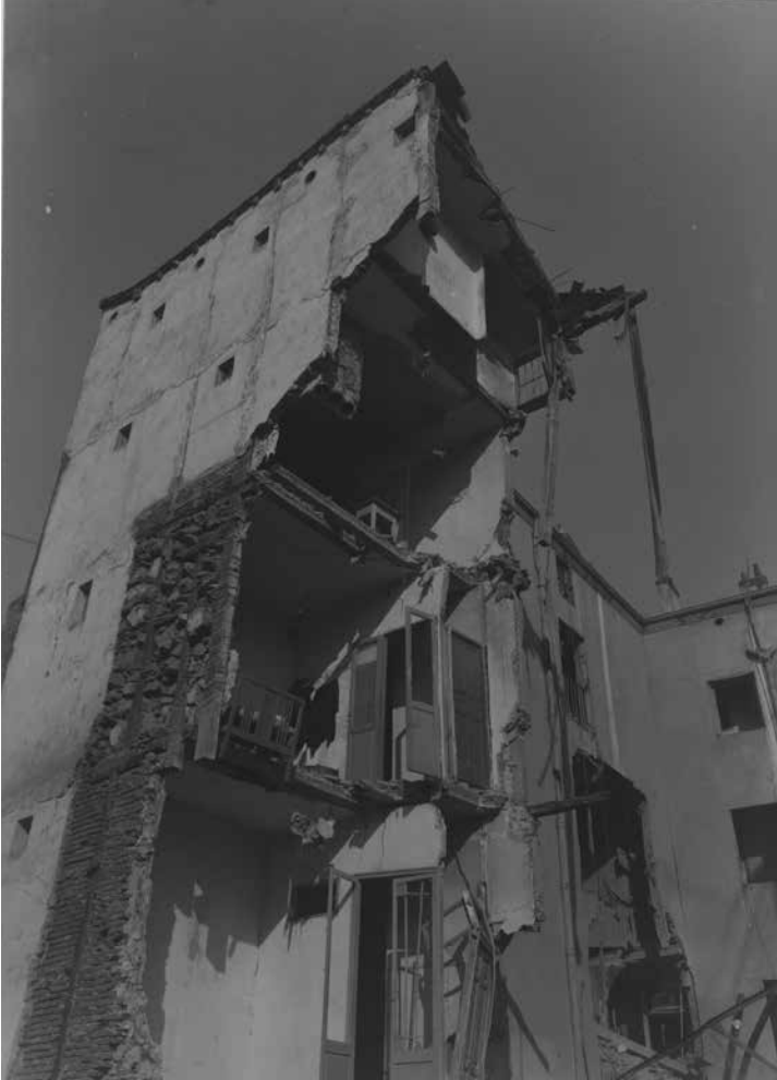
Figure 1.7. Destroyed building in the Calle Ruda. Photo Luis Lladó. Archivo Rojo. Ministerio de Educación, Cultura y Deporte, Archivo General de la Administración, AGA,33,E,04038,53153,001.
